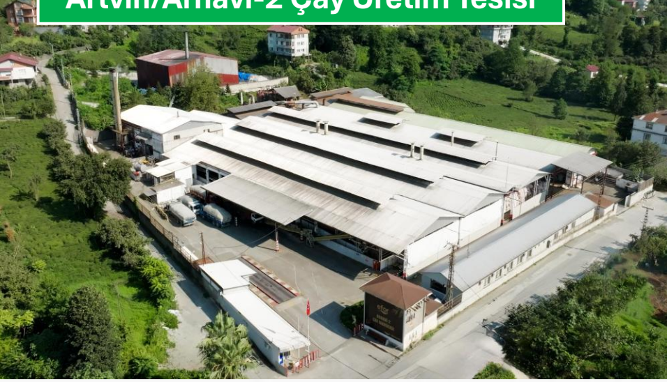
Artvin/Arhavi-2 Çay Üretim Tesisi
