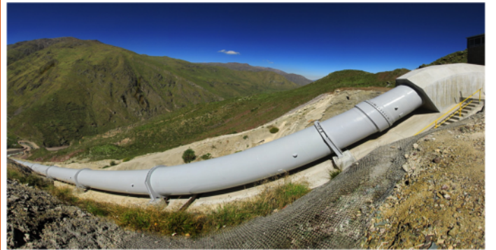
Çukurçay HES Cebri Boru Hattı
