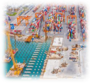
İnşaat & Kazık Boruları
