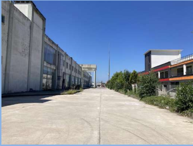
Çarşamba Otogarı Arka Giriş Kapısı
