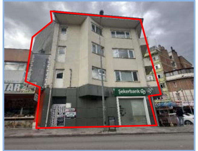
Bina (lojman katları) Girişi ve Cephe Görünümü
