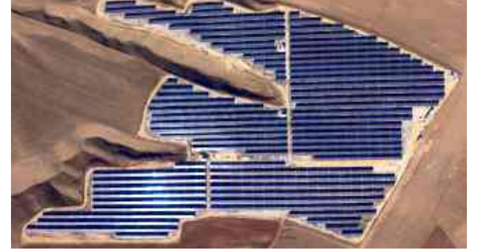
Turkcell Yozgat GES 1-2
