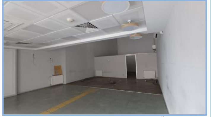
Zemin Kat - İç Görünümü
